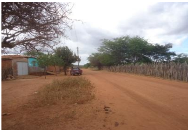
TRECHO DA PAVIMENTAÇÃO
