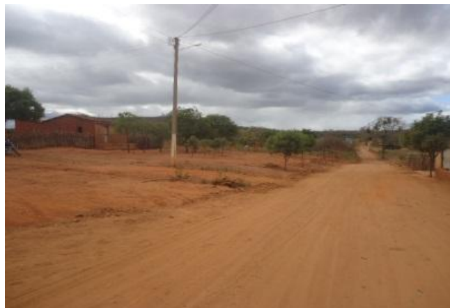
TRECHO DA PAVIMENTAÇÃO
