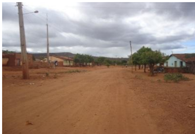
INÍCIO DA PAVIMENTAÇÃO
