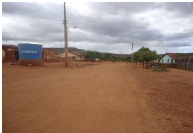
TRECHO DA PAVIMENTAÇÃO
