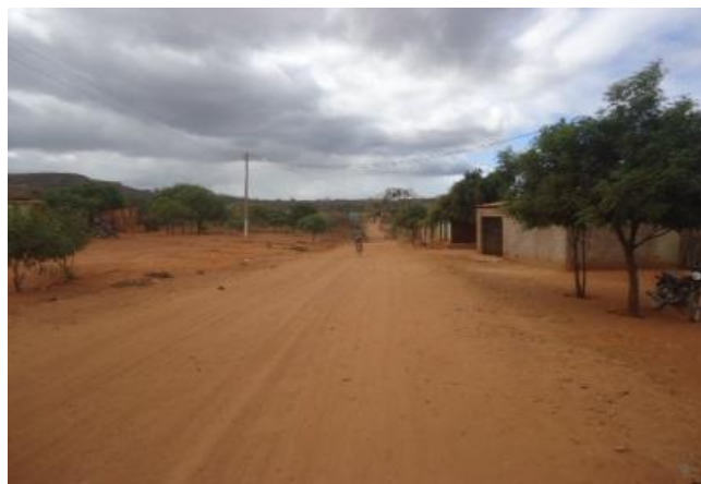
TRECHO DA PAVIMENTAÇÃO
