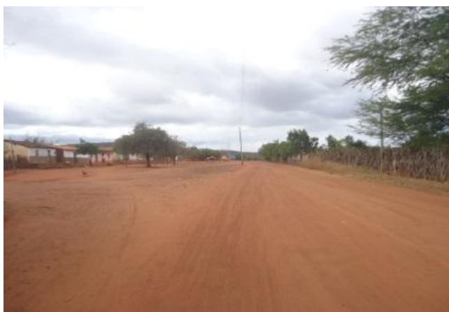
TRECHO DA PAVIMENTAÇÃO
