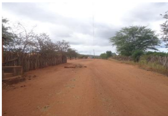
TRECHO DA PAVIMENTAÇÃO
