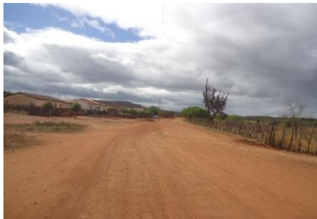
FINAL DA PAVIMENTAÇÃO
