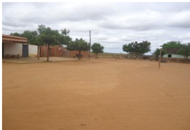
INÍCIO DA PAVIMENTAÇÃO
