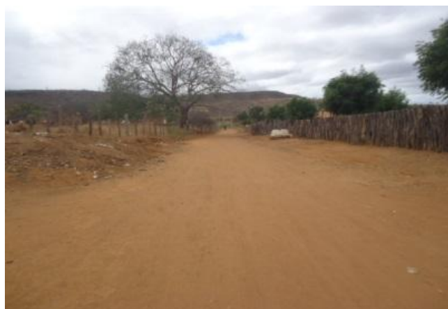
TRECHO DA PAVIMENTAÇÃO
