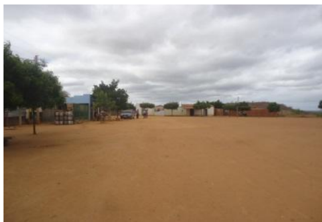
TRECHO DA PAVIMENTAÇÃO
