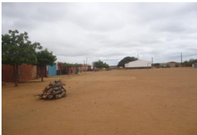
INÍCIO DA PAVIMENTAÇÃO
