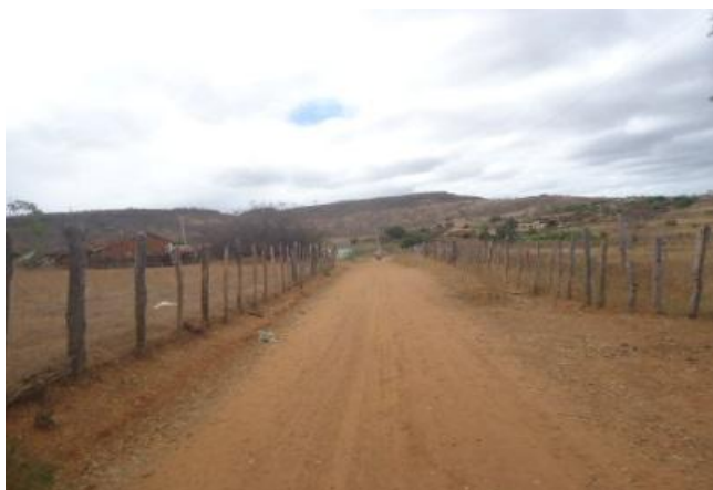
TRECHO DA PAVIMENTAÇÃO
