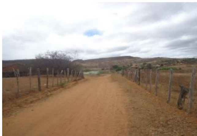
TRECHO DA PAVIMENTAÇÃO
