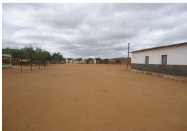
TRECHO DA PAVIMENTAÇÃO
