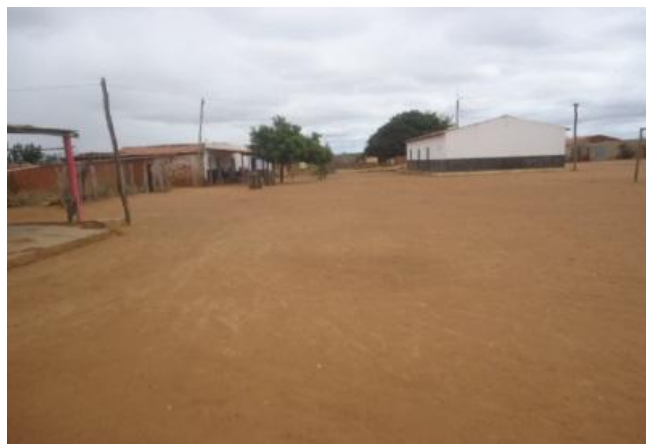
TRECHO DA PAVIMENTAÇÃO
