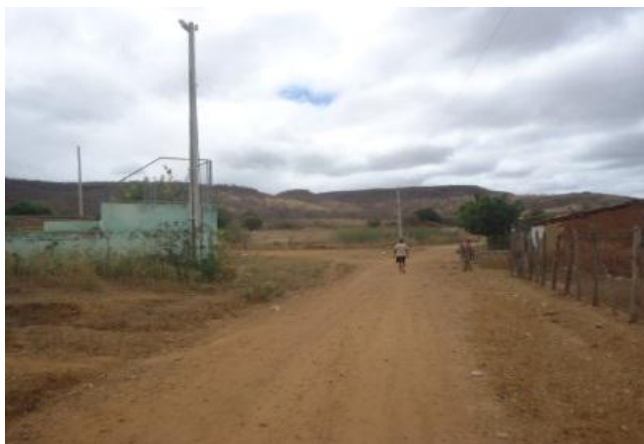
INÍCIO DA PAVIMENTAÇÃO
