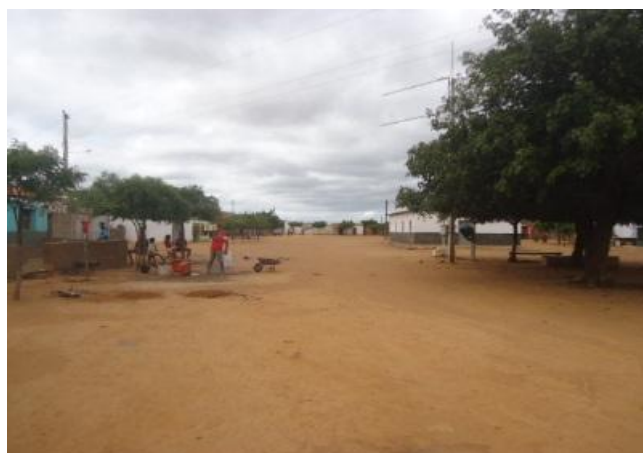
FINAL DA PAVIMENTAÇÃO
